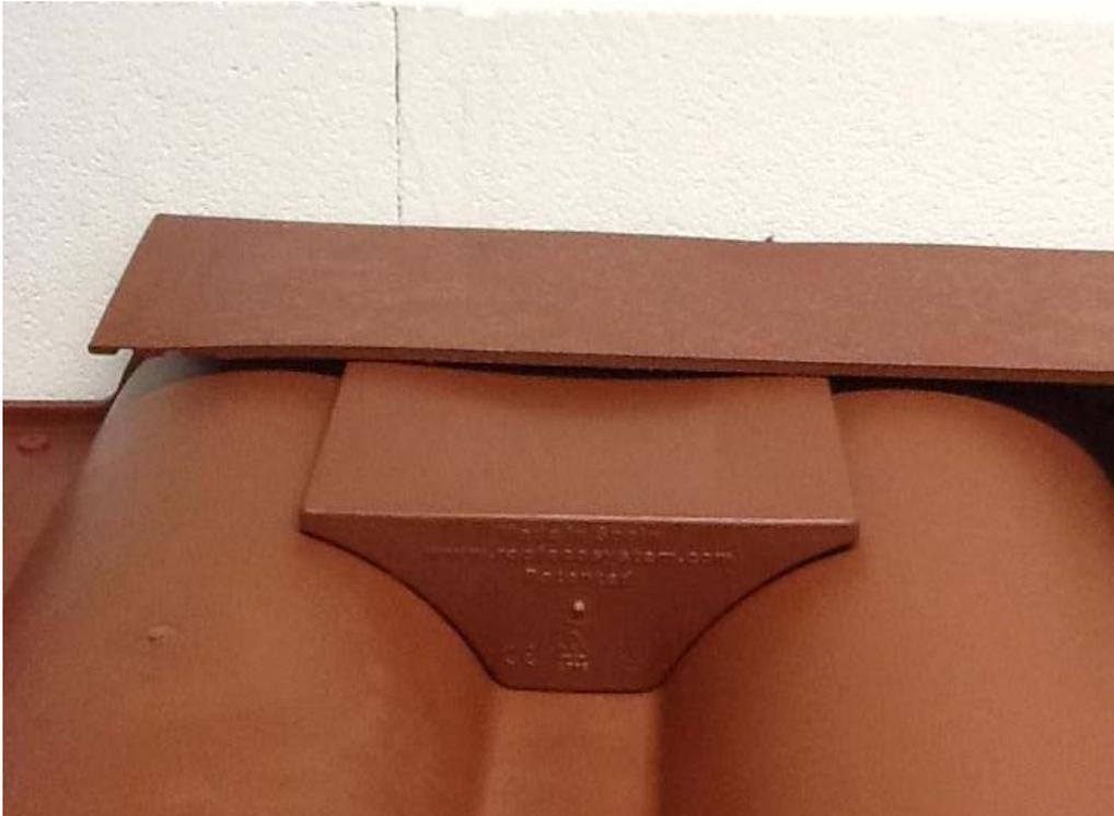
O angular adere à parede e dever-se-á colocar um cordão de poliuretano entre a parede e o lateral para evitar infiltrações de água; também se coloca o fecho da cumeeira para que a água não se filtre pelo canal.
