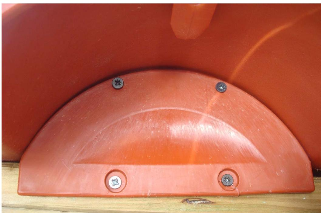
Para se fixar na cumeeira e no espigão é necessário colocar 2 tampas da seguinte forma. Sobrepõem-se 2 cm, parte 1 na parte 2, e aparafusa-se (com
