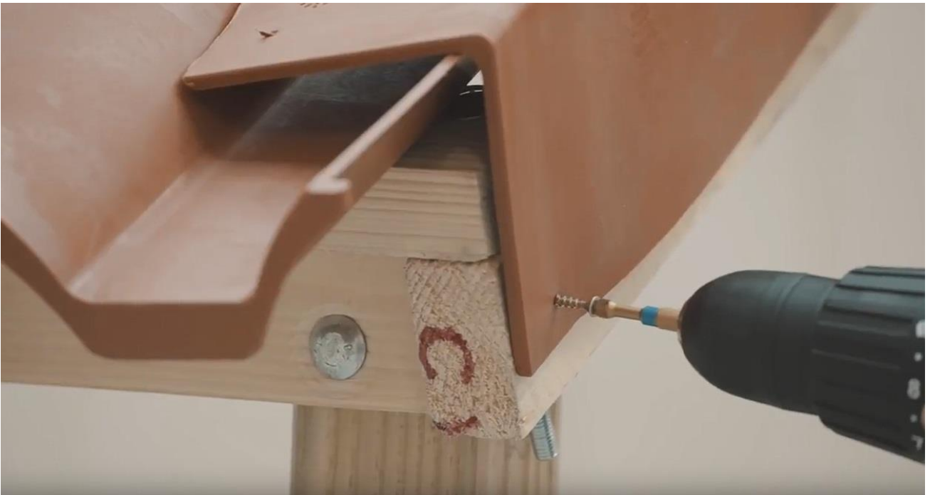
Foto Seitenabschluss mit Kanal
